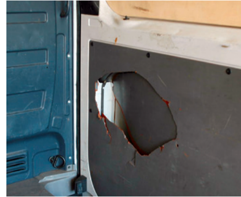
Bruch der Verkleidung
